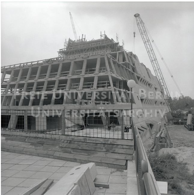
Baustelle, Befestigung der Außenplatten an der Westseite, 23.8.1975 Quelle: Universitätsarchiv der FU, RF/0231-10, Foto: Reinhard Friedrich
