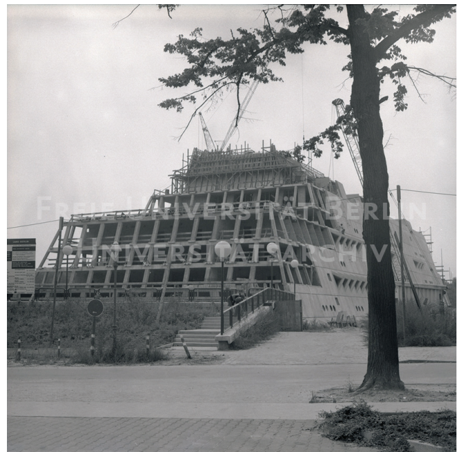
Baustelle, Blick von der Krahermerstraße, Befestigung der Außenplatten an der Westseite, 23.8.1975 Quelle: Universitätsarchiv der FU, RF/0231-11, Foto: Reinhard Friedrich
