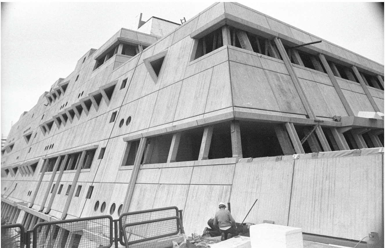
Rohbau, Kopfbereich Nordost, runde Öffnungen für Luftansaugrohre, 17.10.1975
