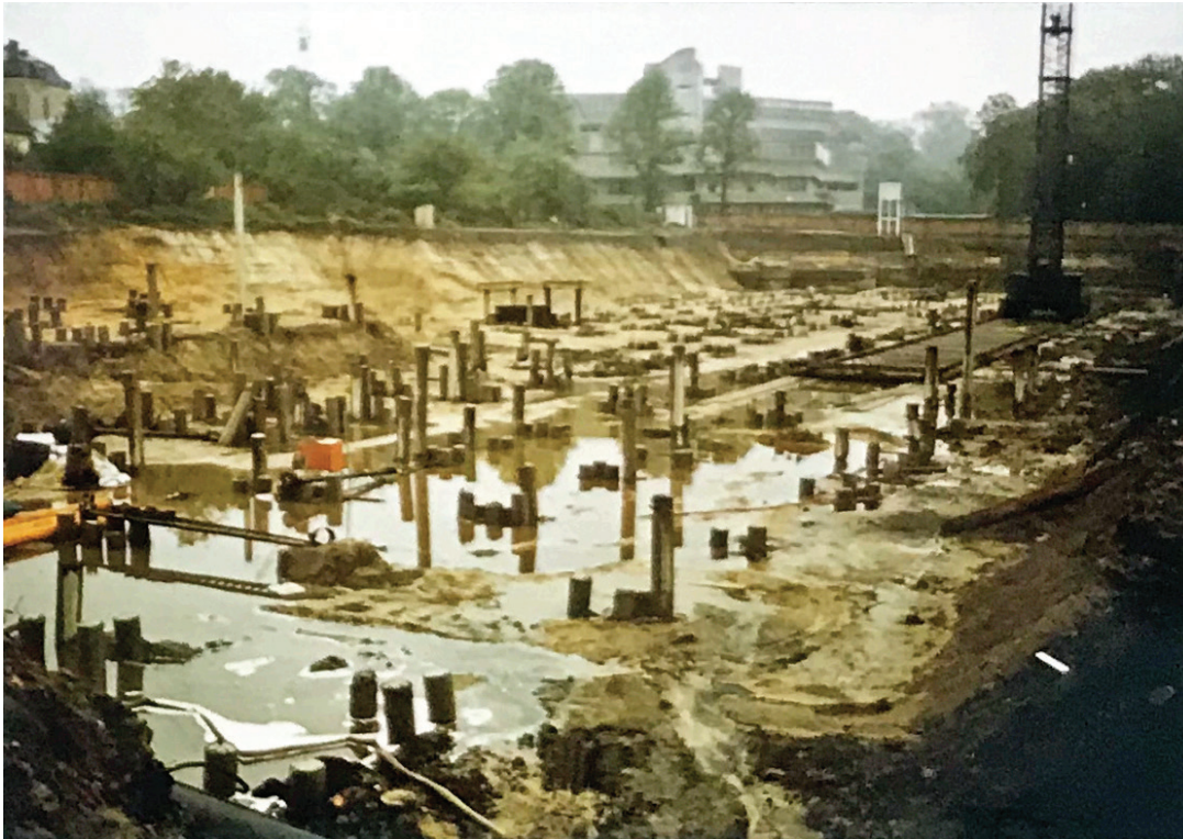
Pfahlgründung, Blick Richtung Hygieneinstitut, 1971
