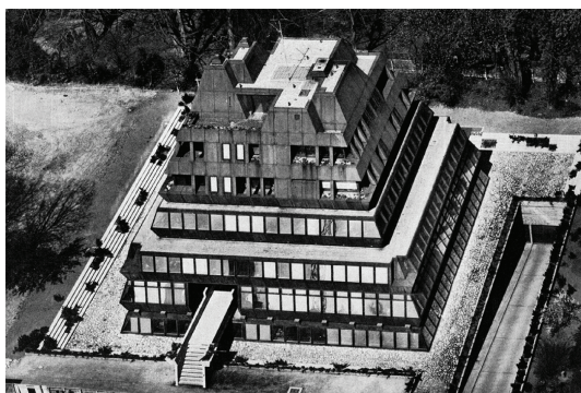
Justus Dahinden: Ferrohaus, Zürich, 1970 Quelle: Internet
